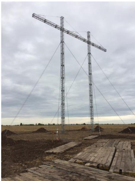
Abbildung 8: Provisorischer Mast mit Erdankern für die Aufnahme eines Systems (Quelle: 50Hertz)
