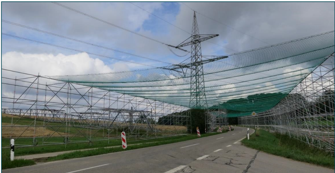
Abbildung 21: Beispiel Stahlgerüst mit Netz
