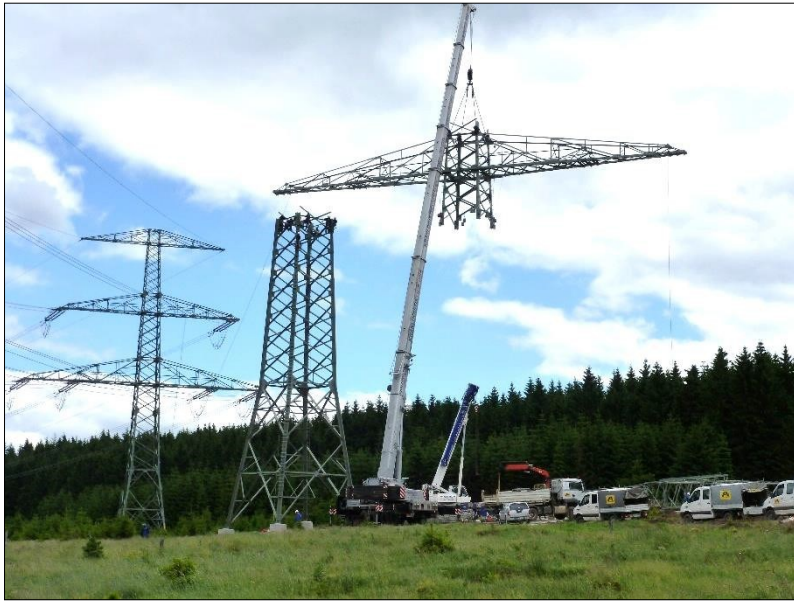
Abbildung 23: Maststocken mit Mobilkran
