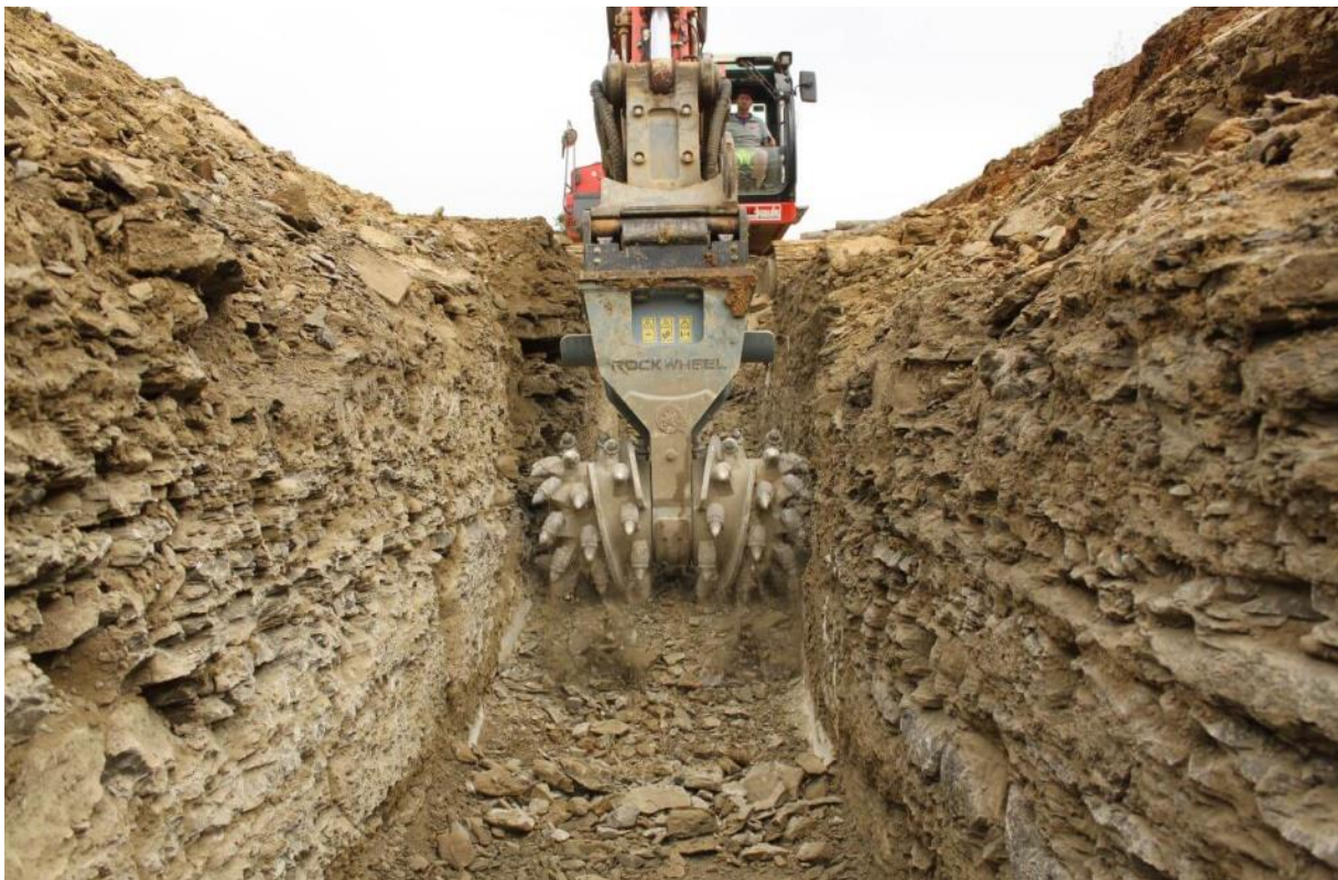
Abb. 2-7: Anbaufräse (Bagger) zur Grabenherstellung (Quelle: www.baumaschinendienst.de ).
