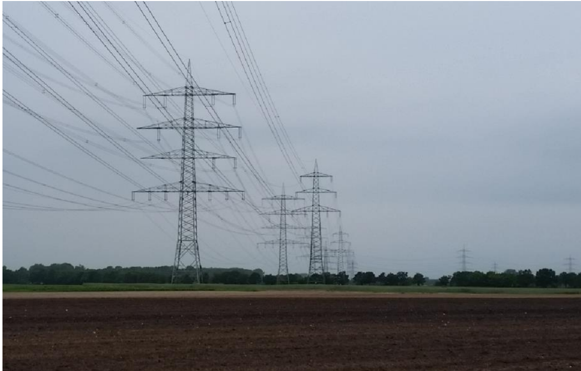
Abbildung 2-7: Leitungsbestand im Abschnitt zwischen Griesheim und Pfungstadt
