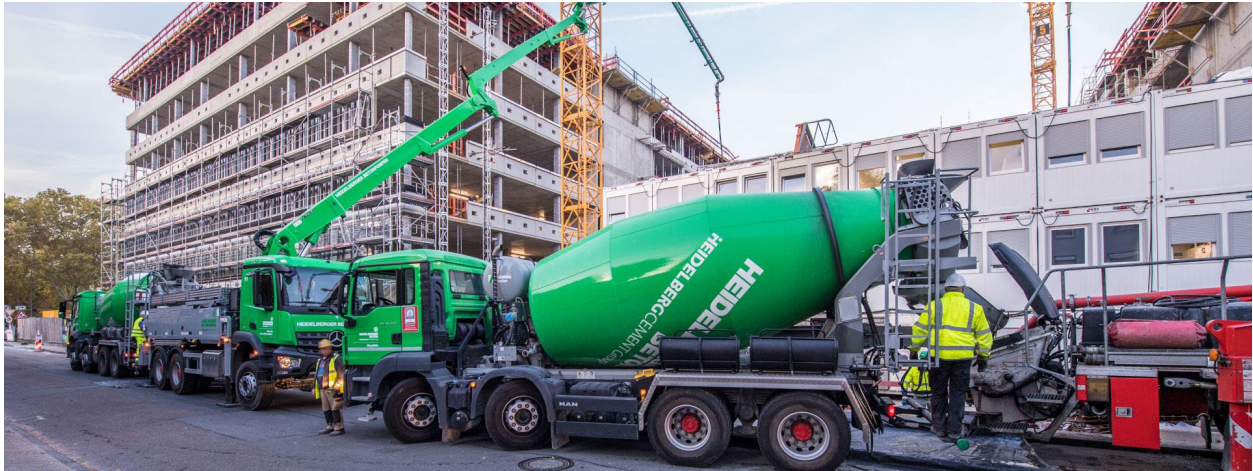
Abbildung 2: Beispielhafte Darstellung einer mobilen Betonpumpe mit ausgefahrenem Schwenkarm (links) und eines Betonmisch-LKW. Der benötigte Arbeitsbereich eines Fahrzeugs entspricht der schematischen Darstellung in Abbildung 1.
