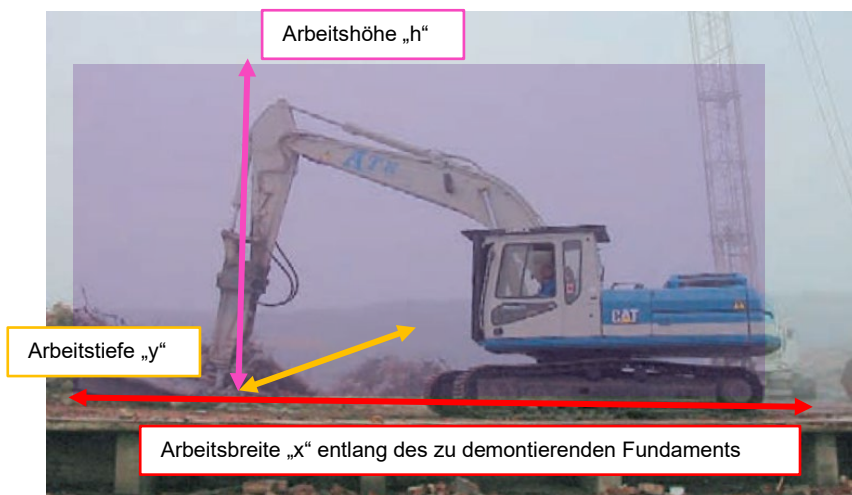
Abbildung 1: Beispielhafte Darstellung des Arbeitsbereichs während der Fundamentabbrucharbeiten mittels Hydraulikhammers
