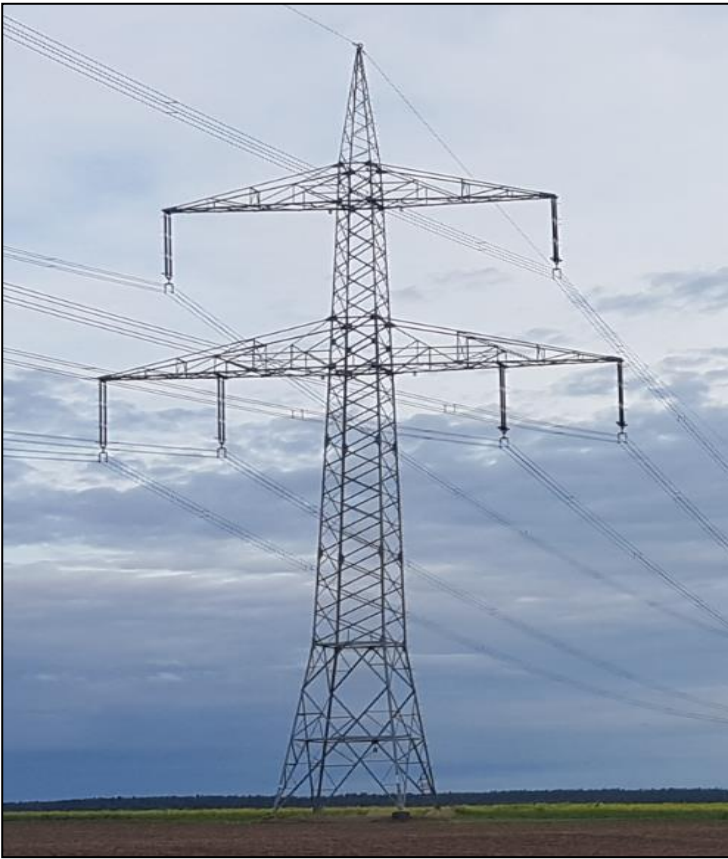
Abbildung 22: 380-kV-Bestandsmast
