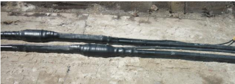
Abb. 7: Fertige Muffen vor dem Verfüllen mit Bettungsmaterial
