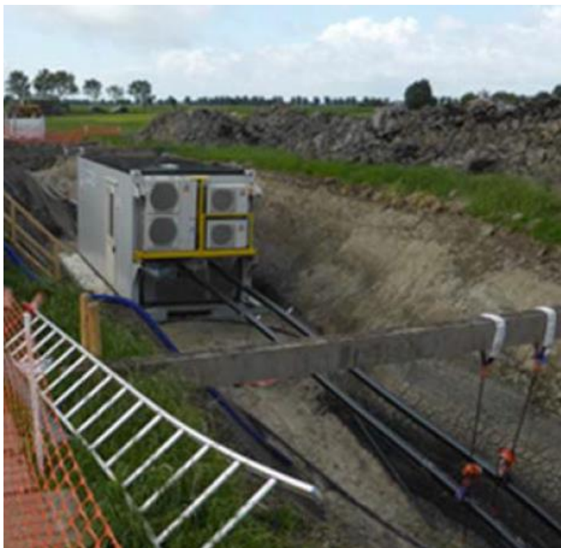
Abbildung 11: Temporärer Muffen-Container
