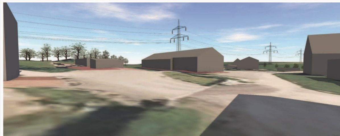
Beispiel B – Bl. 4521, Mast 32: Masterhöhung um 2,5 m
