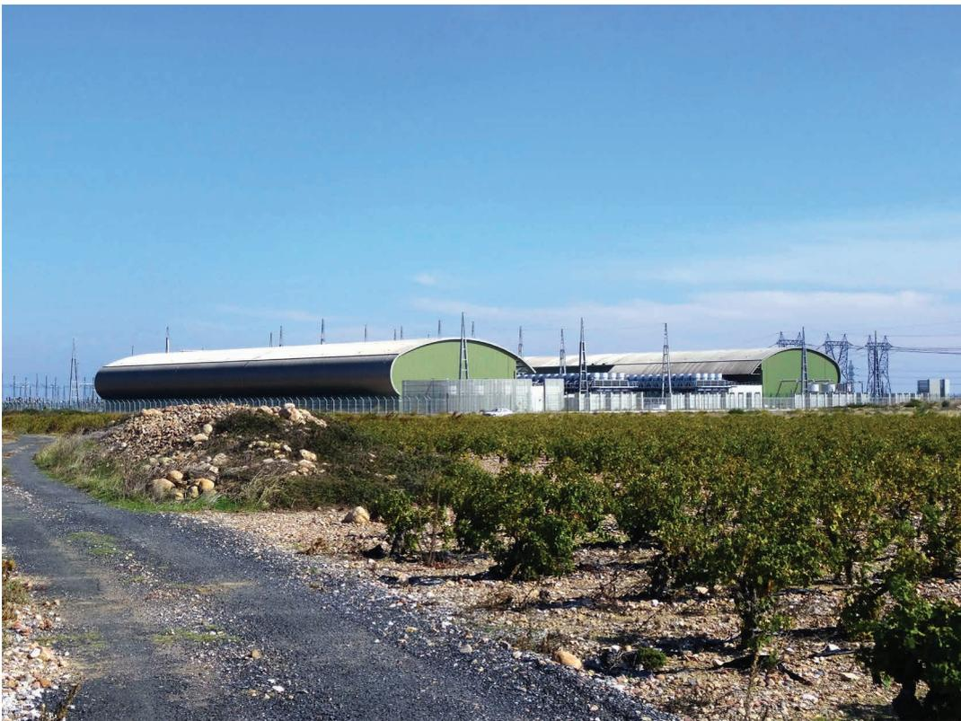
*Die einzelnen Bauteile eines Konverters werden so angeordnet, dass Wirkungen nach außen soweit wie möglich abgeschirmt werden.*
